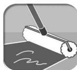
A “queimação” da base é essencial para o processo de colagem. A Cola de Contato **Formica®** deve ser diluída com o Solvente **Formica®** em proporções iguais (50% cola e 50%
